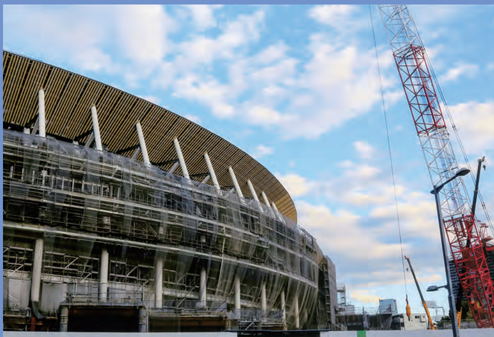
建設中の新国立競技場
