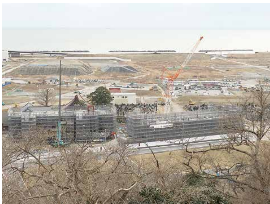
石巻市南浜地区津波復興祈念公園の工事風景（2016年4月）
