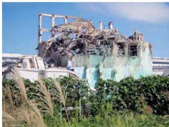
東京電力(株)福島第一原子力発電所 爆発後の3号機原子炉建屋の外観 (東京電力(株)HPより)
